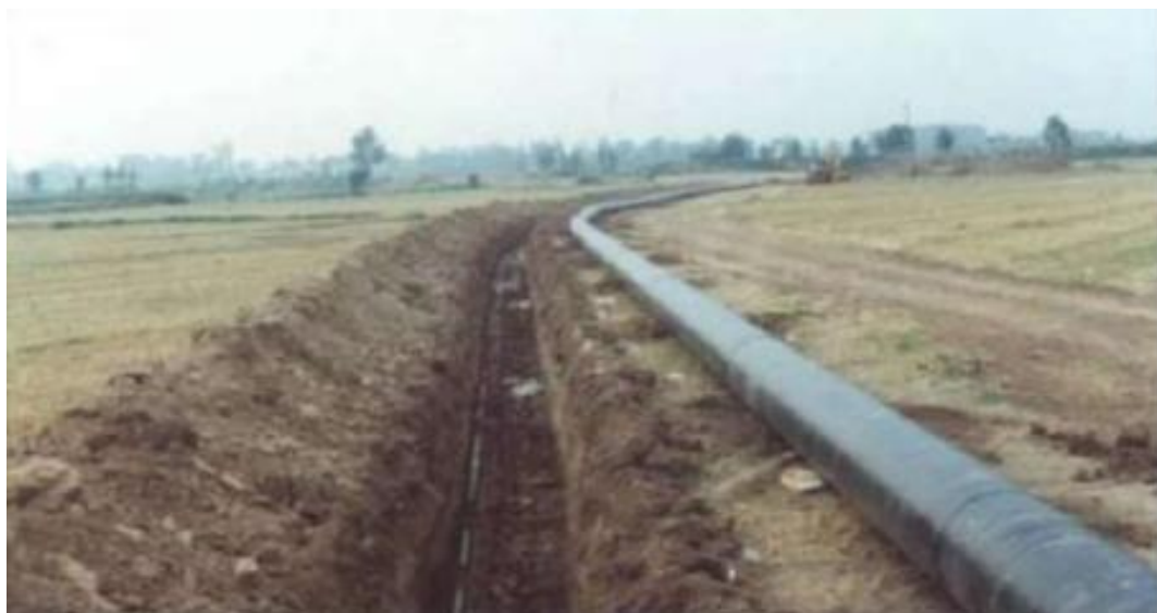
图 3.1-4 国内管沟开挖及布管实景图
